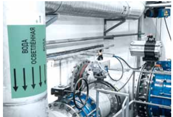
4. Actuadores neumáticos de varios tamaños: esto asegura apertura y cierre confiables de filtros de bancos de arena para las líneas de entrada y salida de caudal para limpieza. (Foto: Festo AG & Co. KG)
