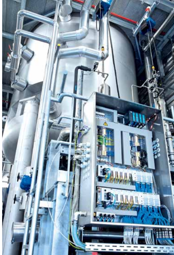
2. Un ejemplo de estandarización exitosa: B. Braun Melsungen AG y su planta de fabricación de soluciones de infusión más moderna de Europa. La estandarización de la automatización permitió a la compañía farmacéutica mejorar de forma significativa la disponibilidad del sistema y a la vez reducir sustancialmente los costos de mantenimiento y repuestos. (Foto: Festo AG & Co. KG )
