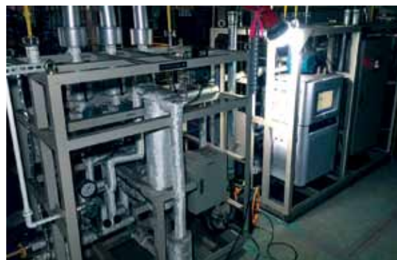
Figura 6. Vista exterior de las estaciones
