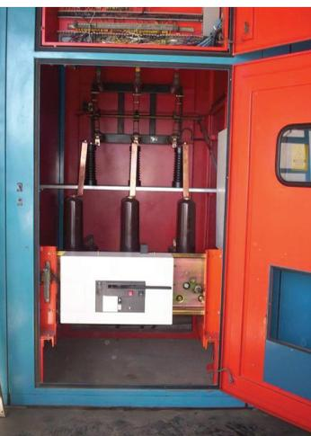
Renovación sobre celda en servicio en la planta Clorox, sita en parque industrial Pilar. Se migró de un interruptor de pequeño volumen de aceite tipo RG-36-800 a uno con tecnología en SF<sub>6</sub> en ejecución fija, adecuando el alojamiento interior y posteriores accionamientos y aumentando la vida útil del tablero en servicio, reduciendo el costo de mantenimiento significativamente y me-
