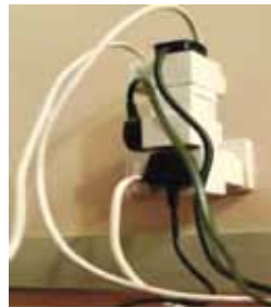
Ejemplo de conexión de triples y adaptadores que interrumpen la conexión del contacto de puesta a tierra, y que pueden generar sobrecargas en los módulos de tomacorriente de la instalación. Prohibida su comercialización por Resolución SICyM 524/98.
