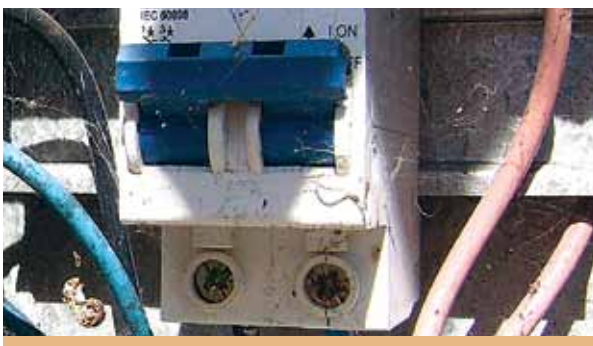
PIA solitario: solo queda espacio para agregar un interruptor diferencial
