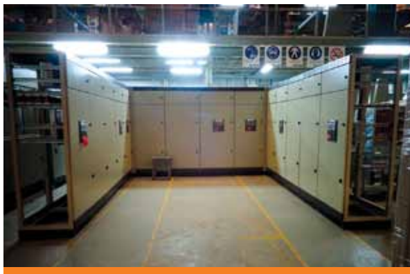
Durante nuestro recorrido vimos el desarrollo de tableros para subestaciones, hospitales, plantas industrias, petroleras, etc.
