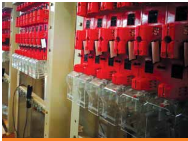
Tecniark lleva a cabo tareas de ingeniería, fabricación y entrega los tableros con todos los componentes listos para su montaje e instalación
