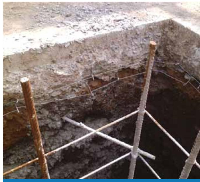
Armaduras de bases de hormigón armado (tomadas de tierra de cementos).
