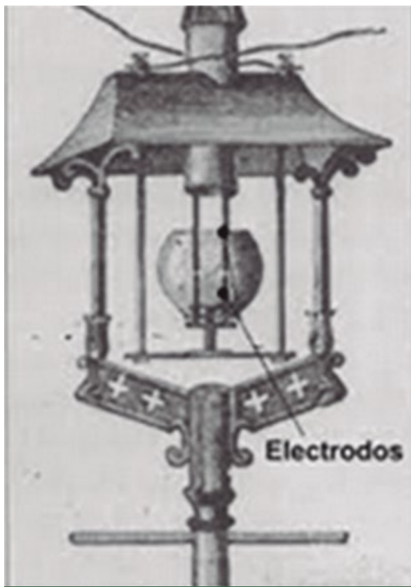
Ejemplo de lámpara de arco, con doble juego de electrodos, empleada en alumbrado público hacia 1885.
