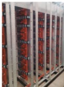
Cabina con tablero Logstrup de 5000 A
