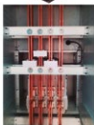
Cabina con tablero Logstrup de 5000 A
