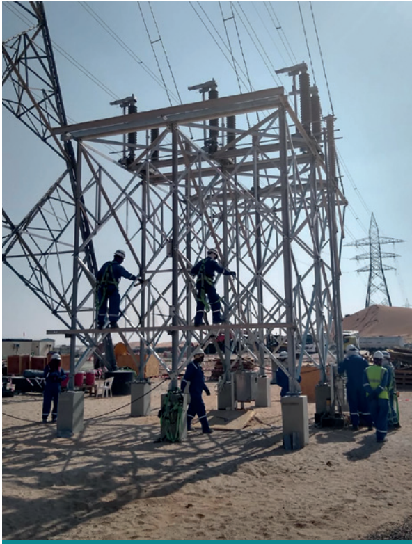
Montaje del seccionador en el desierto de Asab, en los Emiratos Árabes Unidos.
