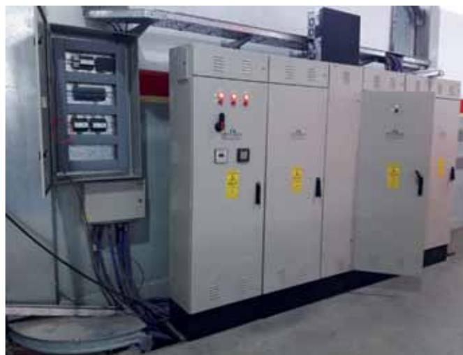
Figura 5. Tablero seccional del sistema de control DALI
