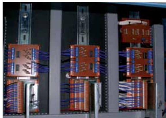
Figura 7. Placas de adaptación de interfaces instaladas
