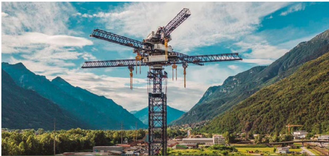
Figura 3. Sistema mecánico de Energy Vault en Suiza
