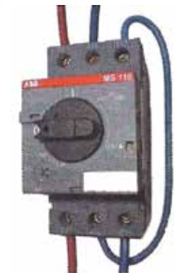
Figura 10. Guardamotor asociado a un MEM
