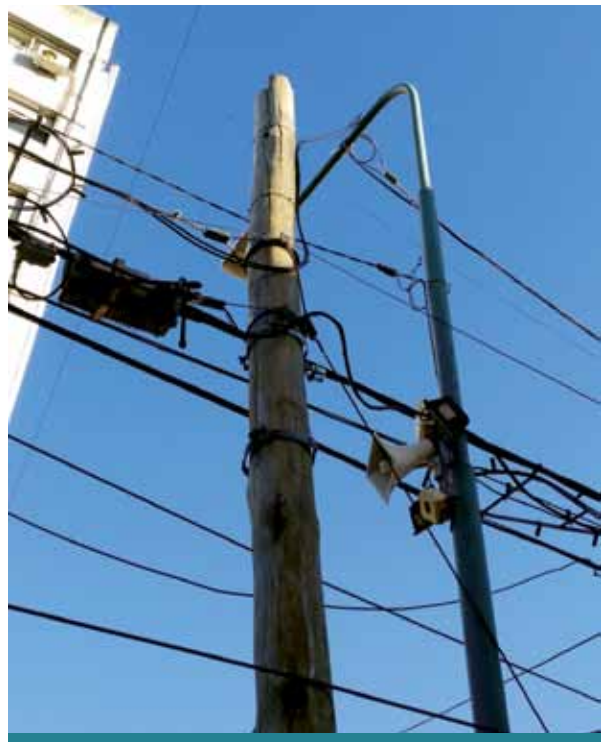
Resultado: el poste perdió su rama fracturada. Ataron la línea invasora (menos mal que ahora con tiro reducido) al brazo de la columna, provocando, además, un esfuerzo axial
