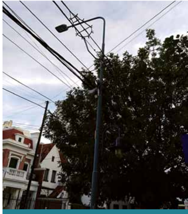
Columna de alumbrado pública próxima invadida
