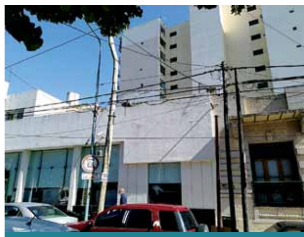
Panorámica de la invasión. Nótese el poste fracturado en su cima a causa de la solicitación mecánica extrema causada por el tiro exagerado de una línea invasora
