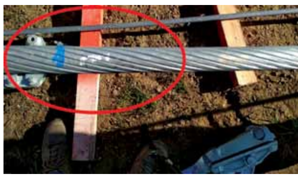
Figura 18. Daños por no emplear ranas en tándem
