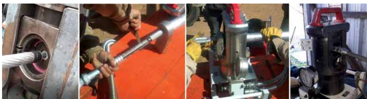
Figura 5. Proceso de compresión de las grapas
