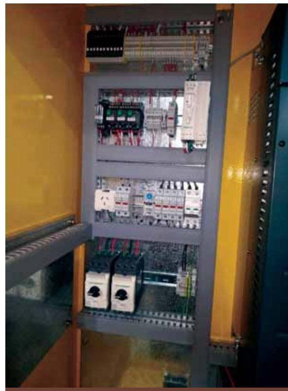
Figura 1. Protecciones internas del tablero de arranque con variador regenerativo para la industria petrolera
