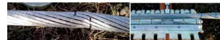
Figura 14. Daños por emplear ranas no aptas para ACSS
