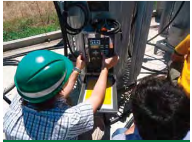
Instalación y puesta en marcha por técnicos de Myeel de equipos ITB
