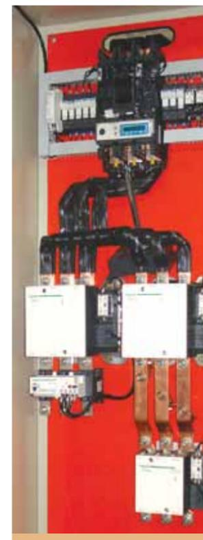
Figura 7. Tablero estrella-triángulo
