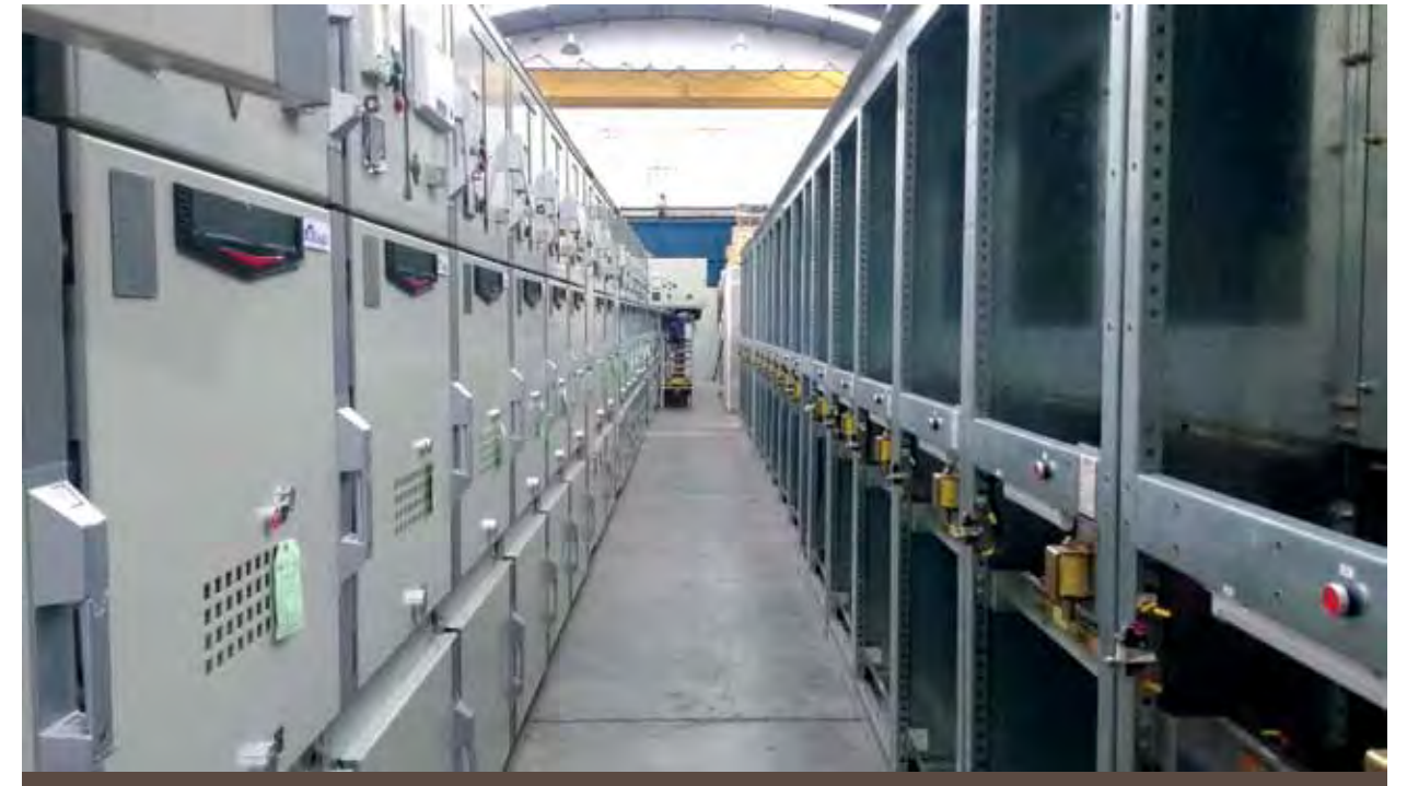
Lago Electromecánica está construyendo su nueva planta en Ezeiza para concentrar su enorme actividad industrial
