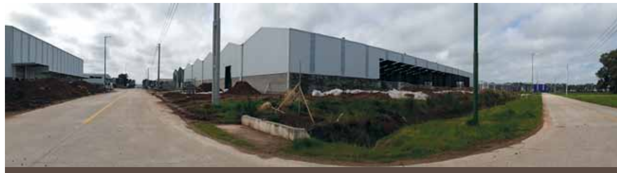
Lago Electromecánica está construyendo su nueva planta en Ezeiza para concentrar su enorme actividad industrial
