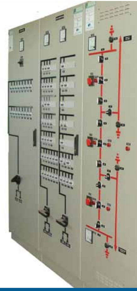
Figura 2. Gabinete fijado al piso
