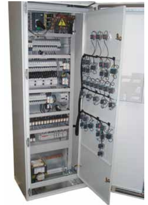
Figura 3. Tablero con doble puerta
