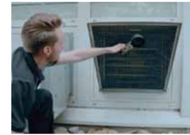
Figura 1. b) Para medir correctamente, la salida de aire solo se cubre con el brazo y el instrumento de medición de modo que el aire pueda fluir sin impedimentos.
