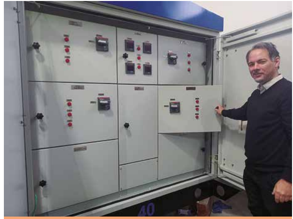
Fernando Molina, gerente comercial de Grupo Facoel. Foto de subestación Compacta
