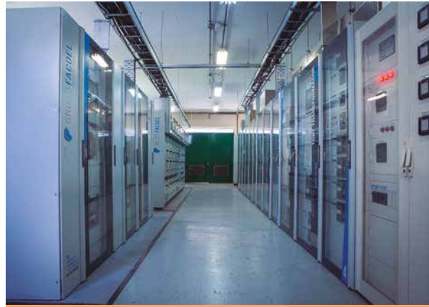
Subestación transformadora de MT/BT realizada por Grupo Facoel
