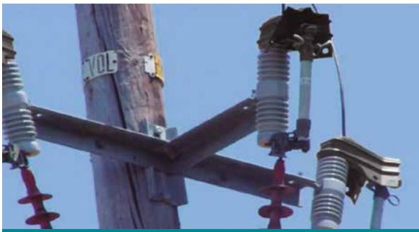
Además del diseño flexible que cubre la mayoría de las formas y tamaños de conductores, la clave está en los materiales de construcción. Todas las opciones se fabrican con materiales termorretráctiles, reticulados por radiación y de alta resistencia dieléctrica, gracias a lo cual brindan una alta resistencia térmica en todo el rango de temperaturas de funcionamiento de los equipos involucrados.
