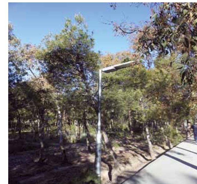
Figura 10. Instalación correspondiente a la primera etapa
