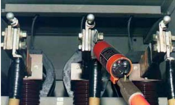
Mide 60 milímetros de diámetro y 180 de largo, pesa aproximadamente 290 gramos y se alimenta con baterías de nueve volts. Propicio para aplicaciones interiores y exteriores, la carcasa es de polietileno y su diseño redondo hace que todo el dispositivo (*contact tester* y pértiga) sea más liviano, además de favorecer la visualización del usuario.
