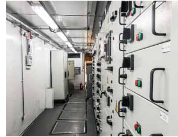
Figura 14. Interior del shelter: tableros e instalación de iluminación
