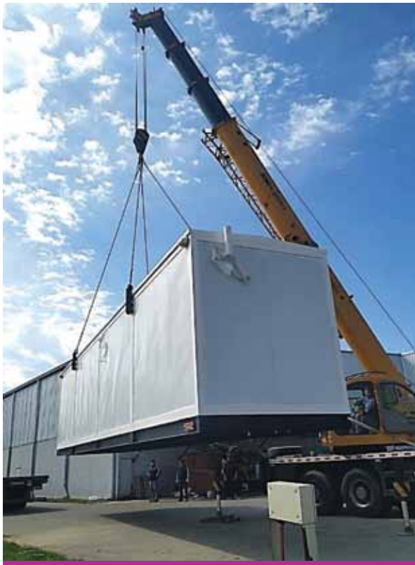
Figura 13. Detalle de izaje de shelter de 13,3 metros de largo con eslingas
