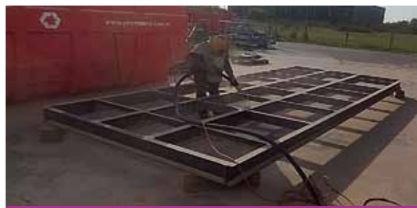
Figura 4. Tratamiento del bastidor de piso
