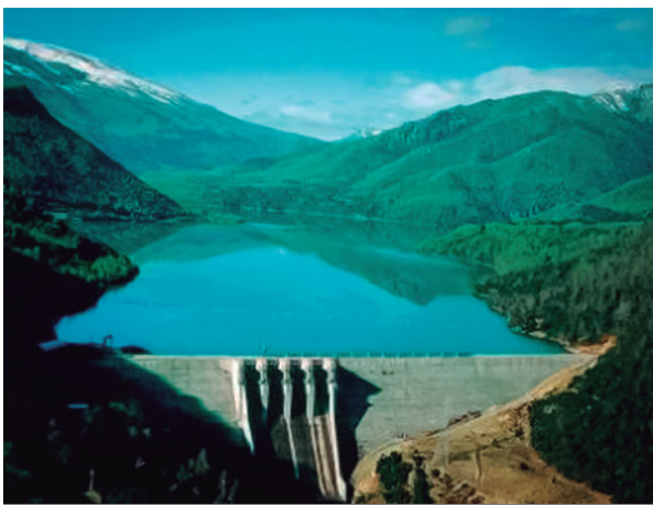
La planta hidroeléctrica Ralco de 690 MW
