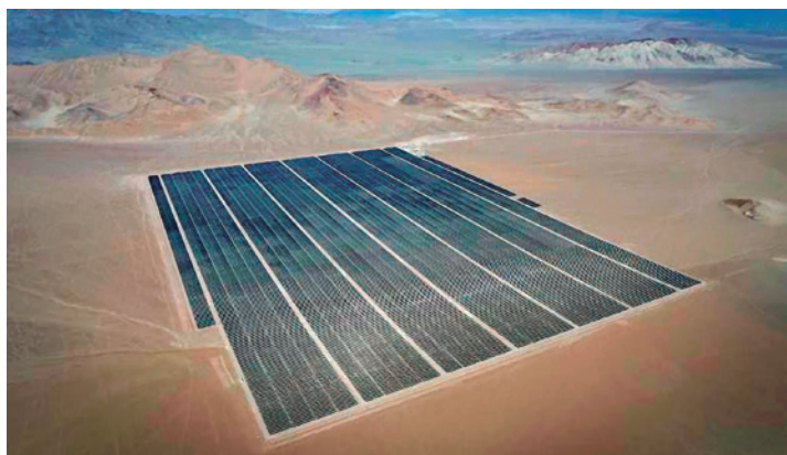
El proyecto de generación de energía fotovoltaica Salvador de 70MW ubicado en el desierto de Atacama
